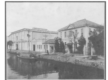
深川本社事務所と鉄筋コンクリート倉庫
