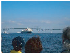
デッキから見るゲートブリッジ
