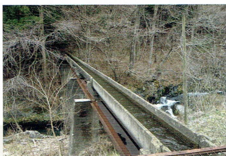
風景に消えていきそうな気仙川に架かる水路橋。コンクリートと鉄だけで出来た美しい造形
